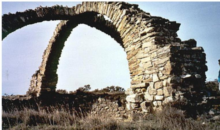
Fig. 5: Estructura que soportaba la cubierta de la nevera de Grávalos
